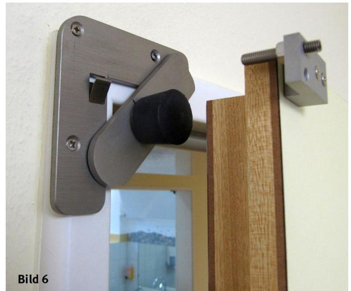
Der oben an der Zarge montierte Puffer klappt beim Öffnen der Tür nach unten und verhindert, dass die Kinder die Tür wieder schließen können bzw. dass die Tür komplett schließt.
