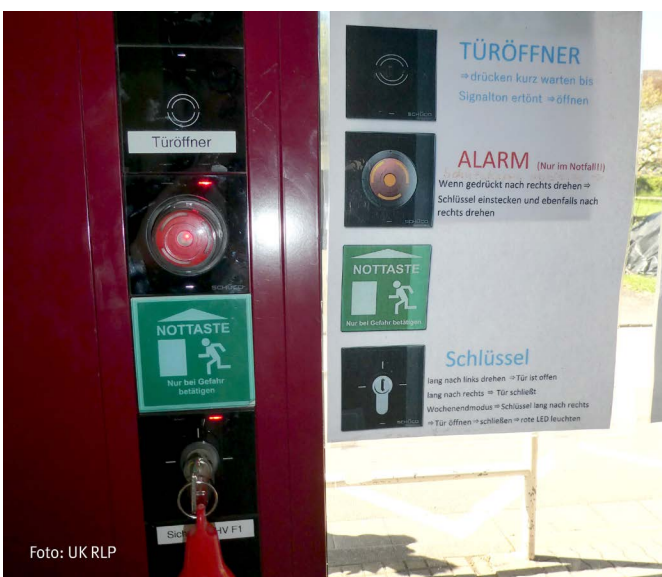
Elektrische Türsicherung
