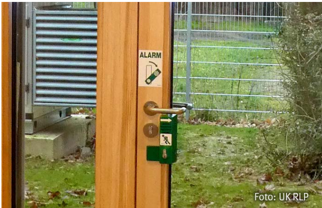
Bild 1: Notausgangstür mit Alarmsicherung
